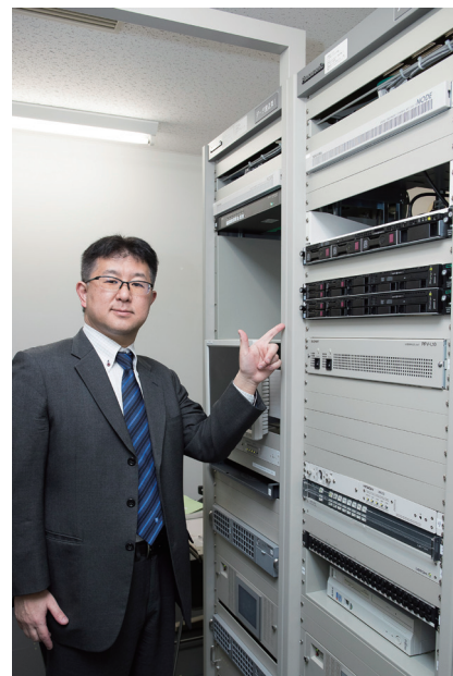
チューリップテレビの放送センターで運用中の「DataCaster Cloud M3」。黒崎氏が示しているのは送出装置、監視装置で、CMSなどの運用機能はクラウドから提供されている
